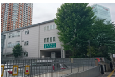
第一庁舎(西棟)
